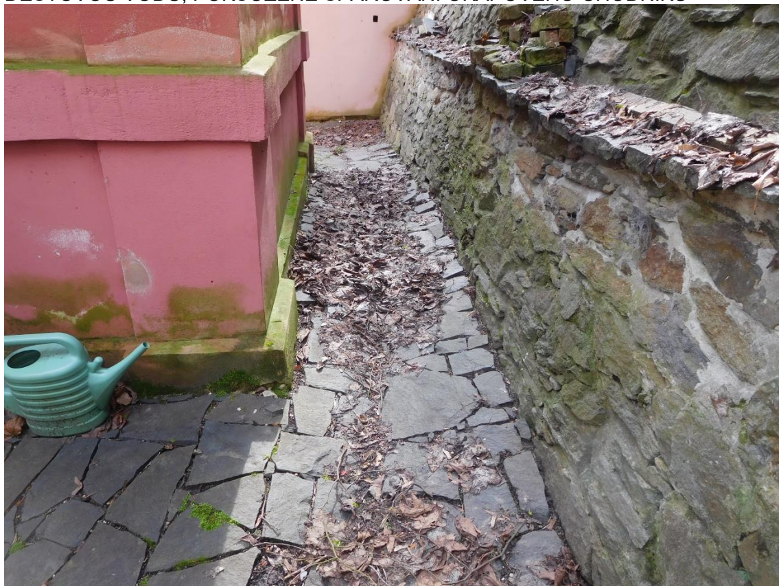
POŠKOZENÉ SOKLOVÉ PARTIE KAPLE VLHKOSTÍ, POŠKOZENÝ OKAPOVÝ CHODNÍK
