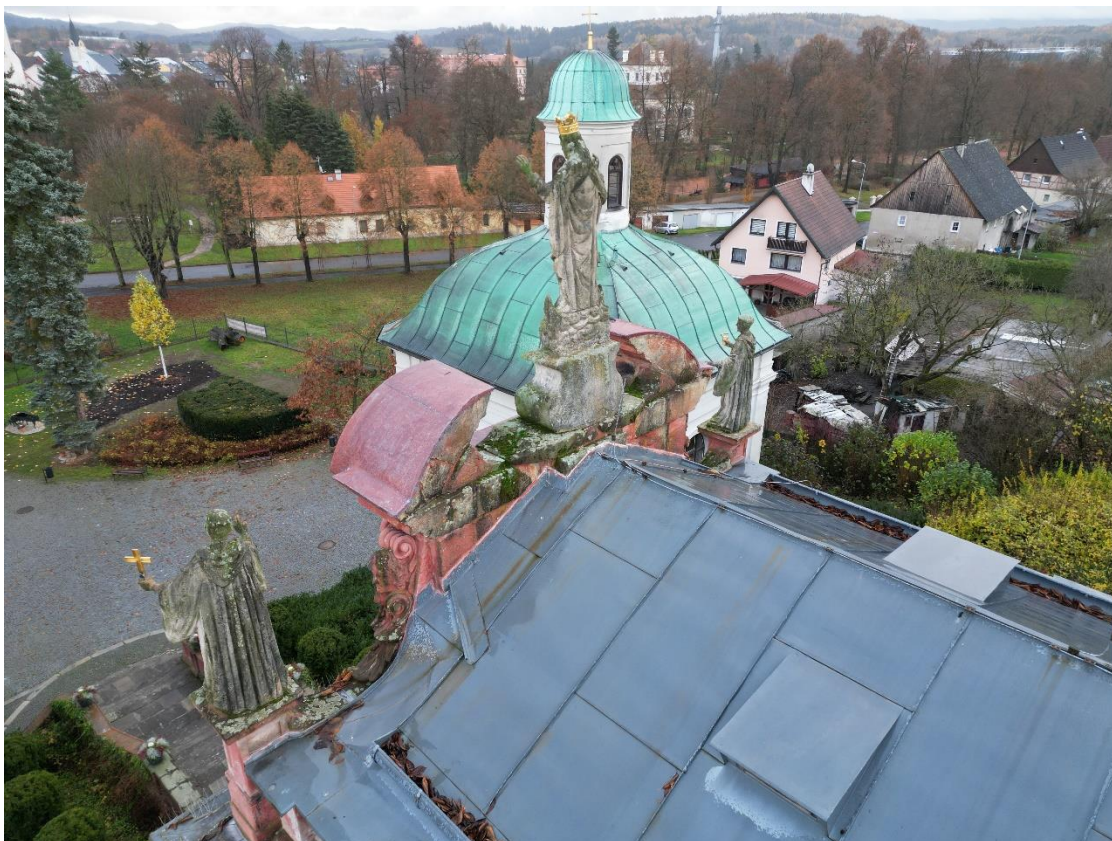
POHLED NA ZADNÍ ŠTÍT KAPLE – POŠKOZENÍ MIKROORGANISMY A VLHKOSTÍ
