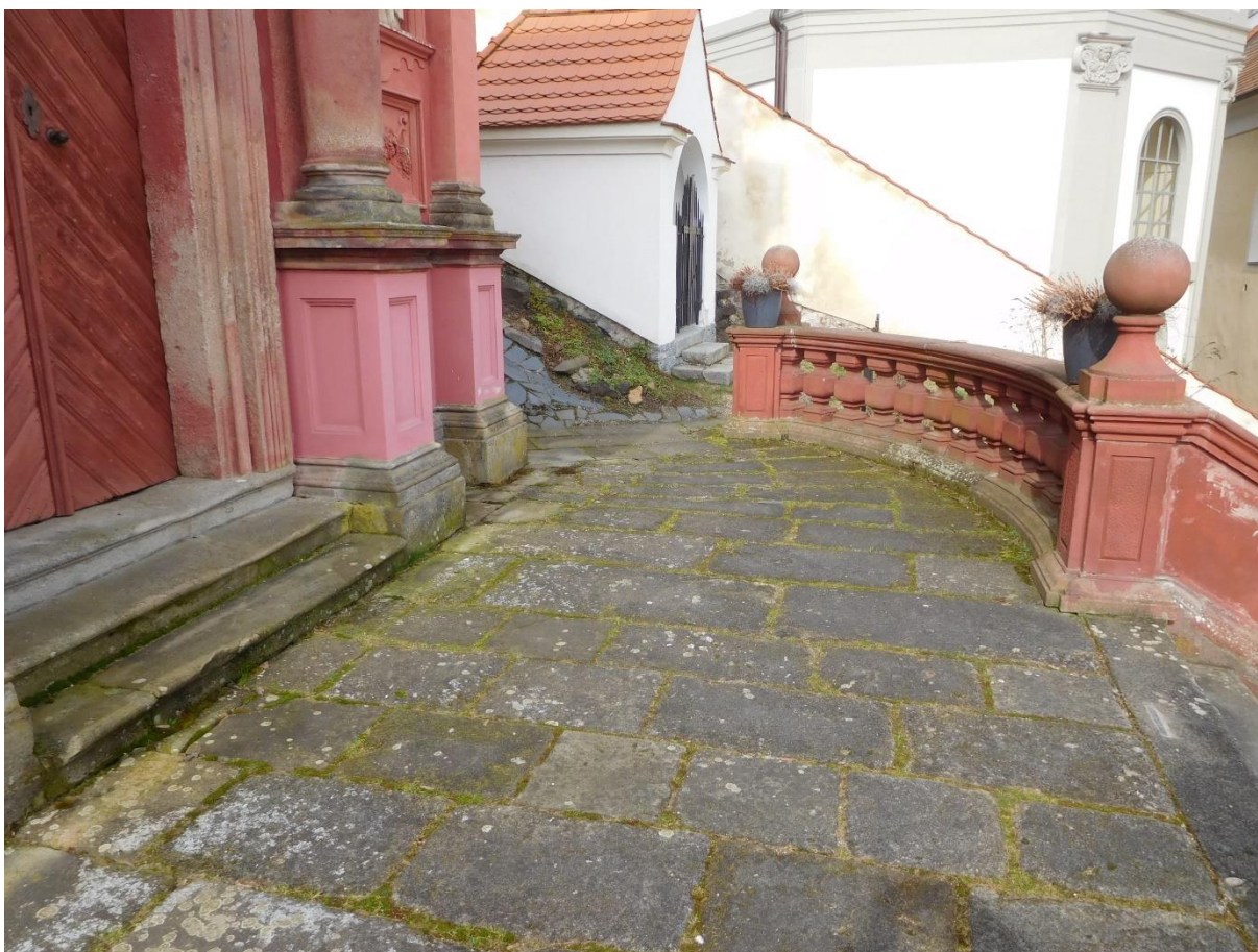
PŘEDPROSTOR KAPLE – NESOUDRŽNÉ SPÁROVÁNÍ, NÁLETOVÁ ZELENĚ
