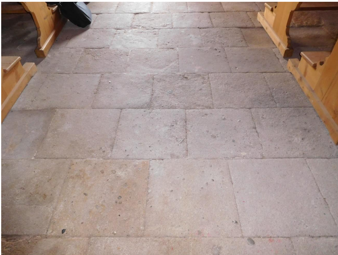
STÁVAJÍCÍ PODLAHA KAPLE – LOKÁLNĚ POŠKOZENÝ A VYŠLAPANÝ POVRCH
