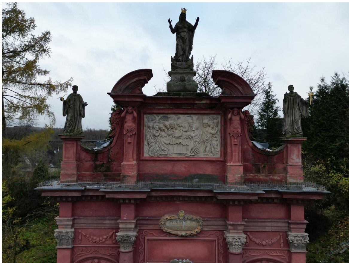
POHLED NA ŠTÍT KAPLE – LOKÁLNÍ POŠKOZENÍ PRVKŮ MIKROORGANISMY A VLHKOSTÍ
