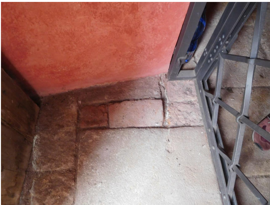
NEVHODNÉ CIHELNÉ VYSPRÁVKY KAMENNÉ DLAŽBY
