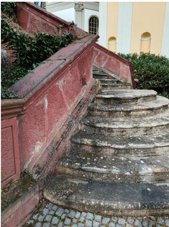
KAPLE S PŘÍSTUPOVÝM SCHODIŠTĚM- POŠKOZENÍ PRVKŮ SCHODIŠTĚ
