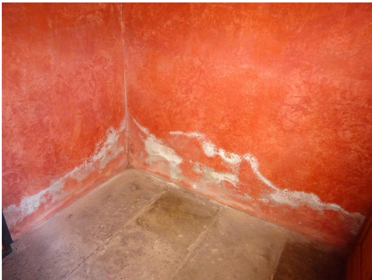
INTERIÉR KAPLE – LOKÁLNÍ POŠKOZENÍ OMÍTEK, PŘEVÁŽNĚ V SOKLOVÝCH PARTIÍCH
