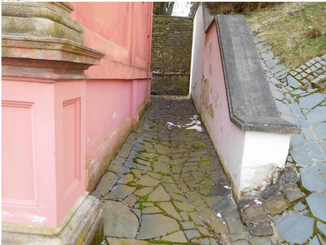
OKAPOVÝ CHODNÍK KOLEM KAPLE, ROZVOLNĚNÉ KAMENY A SPÁROVÁNÍ
