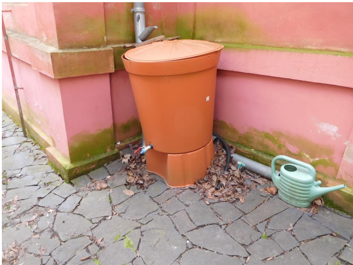
POŠKOZENÍ SOKLOVÝCH PARTIÍ FASÁD VLHKOSTÍ A PŘETÉKÁNÍM SUDU NA DEŠŤOVOU VODU, POKŠOZENÉ SPÁROVÁNÍ OKAPOVÉHO CHODNÍKU
